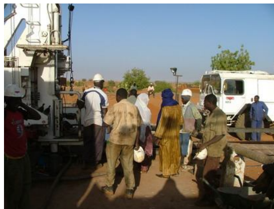
Travaux de forage à Afala
